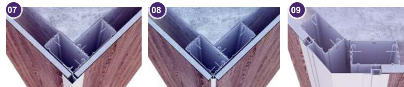
07 Монтаж угла 90° с использованием F - профиля
