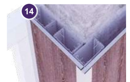
10 Монтаж с использованием L и F - профиля
